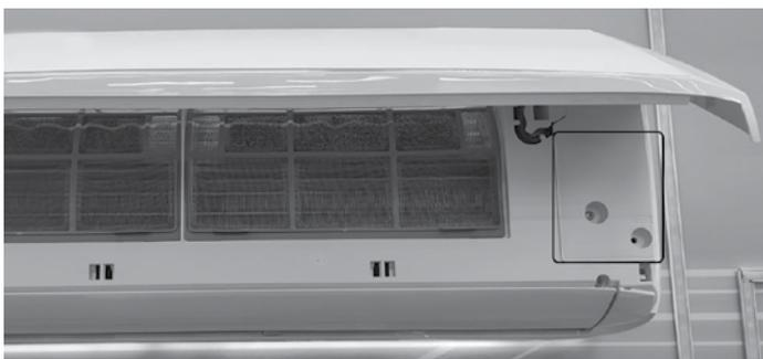
3. Открутите крепежный винт крышки блока электроники и снимите крышку.
